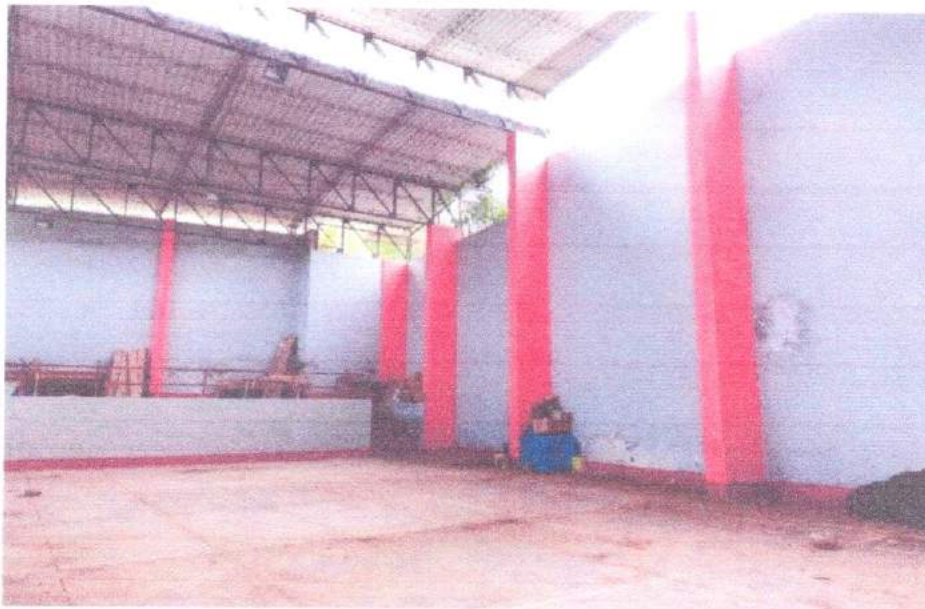
Vista Interior Detalle de Columnas Local Comunal
